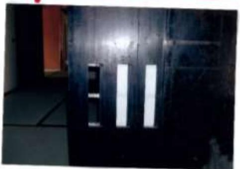
下の写真的障子は横にスライドできるようになっていて、光を取り込んだり、光の調節ができるようになっています。
